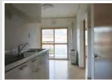
⑥防音サッシ設置(居間)
