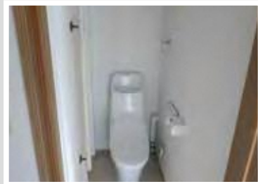
①手すり設置(トイレ)
