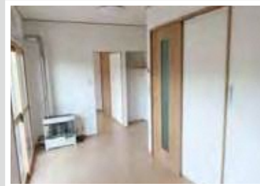
②段差解消(居間・洋室)
