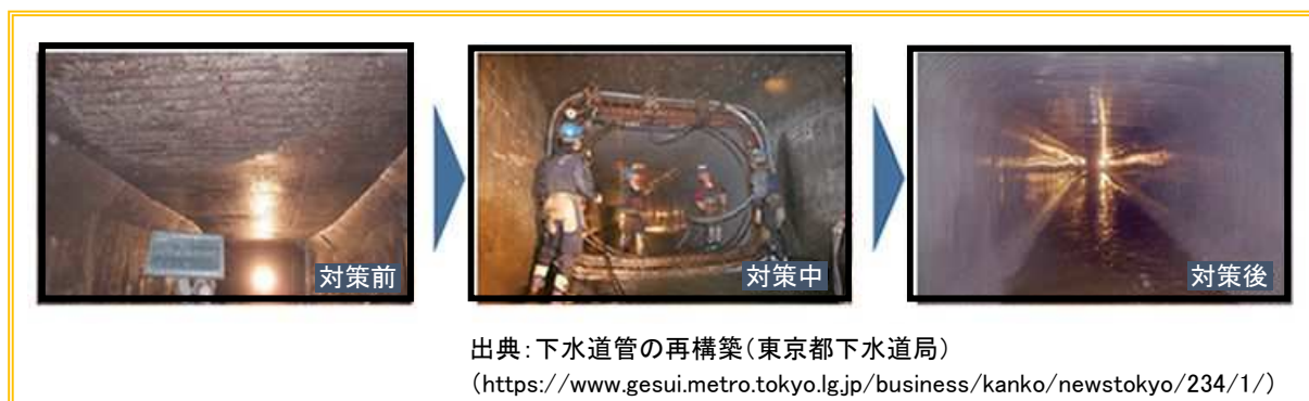
図 4-6 下水道管の更生工法*
