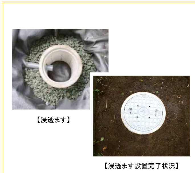
図 4-9 浸透ます設置状況
