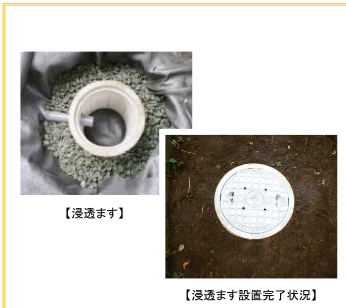
図 4-9 浸透ます設置状況
