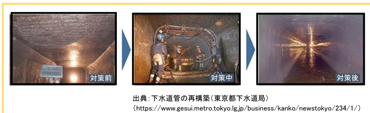
図 4-6 下水道管の更生工法※
