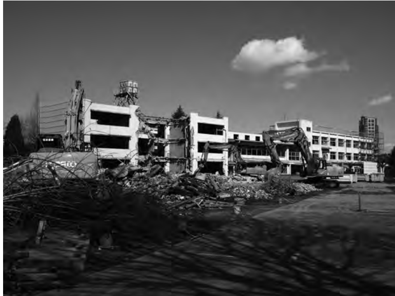
建替に向けて解体中の中原小学校（平成 31（2019）年 3 月）
