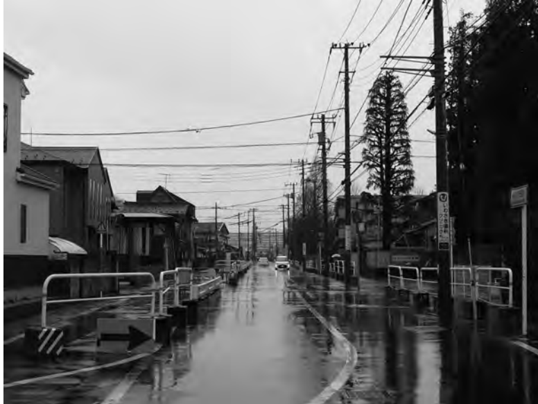
向台中央通りの整備の様子（平成 31（2019）年 3 月）
