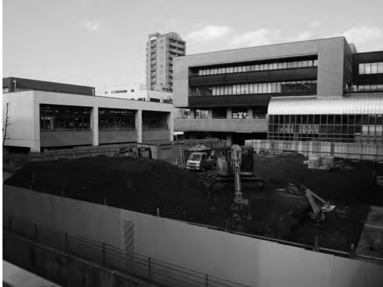
田無庁舎中庭に建設中の仮庁舎（平成 31（2019）年 3 月）
