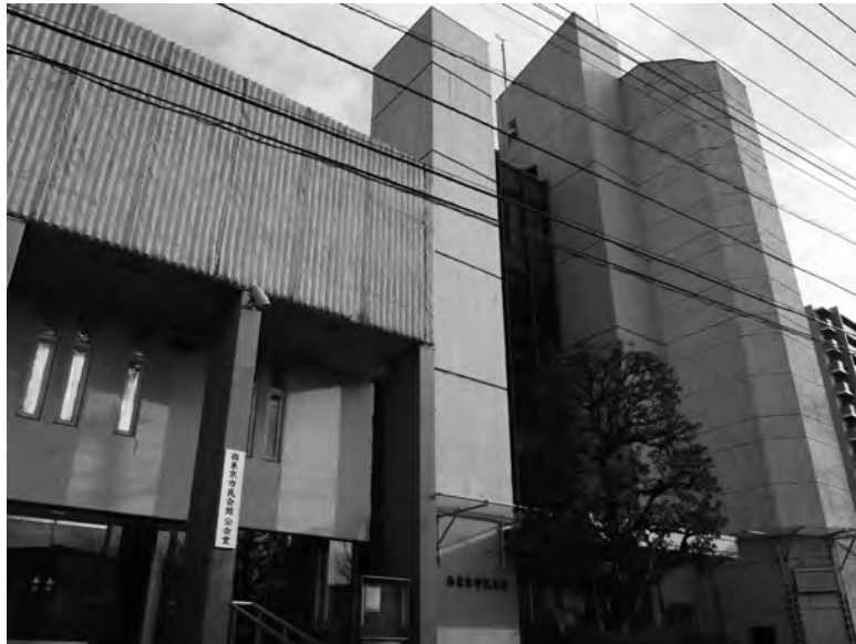
西東京市民会館（平成 31（2019）年 3 月）
