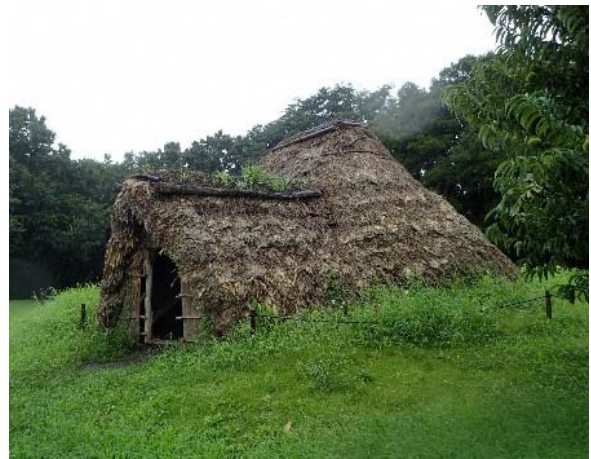
復元建物。竪穴住居（茅葺例） 勝坂遺跡（神奈川県相模原市）例
