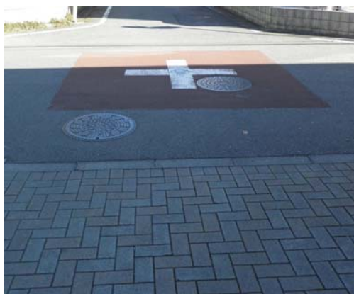
▲交差点カラー舗装
