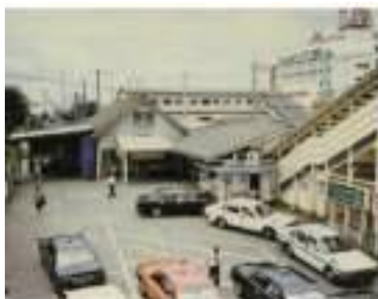
JR中央線 武蔵小金井駅南口
