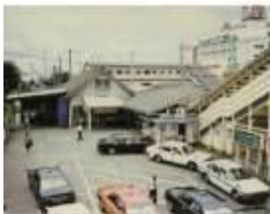
JR中央線 武蔵小金井駅南口
