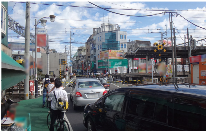
踏切の状況（上石神井第1号踏切道）
