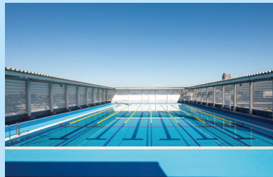
屋上に設置し、プールの水は災害時の消化活動にも使用されます
