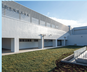
屋上を緑化し環境に配慮しています
