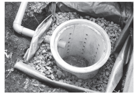
雨水浸透施設
