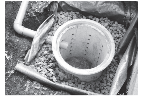
雨水浸透施設
