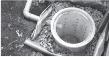
雨水浸透施設
