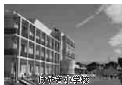
けやき小学校 平成16年1月に開校し、良質な教育を展開する学校施設機能とともに、生涯学習の拠点施設機能を有し、地域に開かれた学校づくりが行われています。
