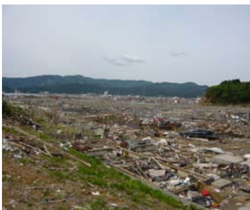
6月23日 陸前高田市の高台から撮影した街並み
