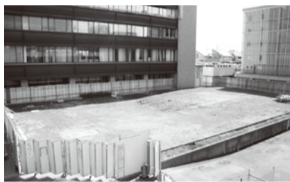
飯庁舎の建設工事中の田無庁舎市民広場
