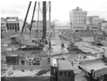
一宮市新庁舎建設現場
