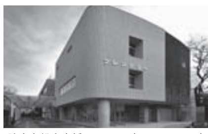
障害者総合支援センター (フレンドリー)
