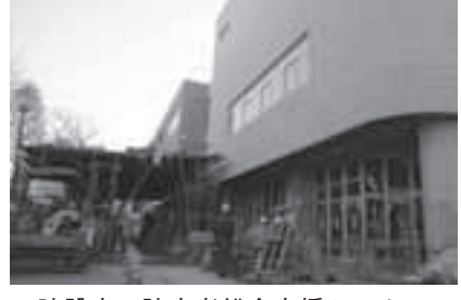
建設中の障害者総合支援センター
