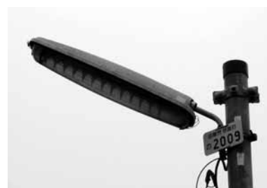
遮光板が設置されている街路灯(谷戸町3丁目)
