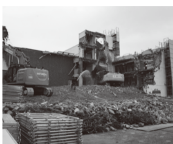
解体工事の様子
