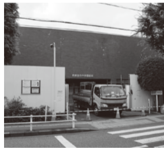
耐震工事のため閉館中の中央図書館
