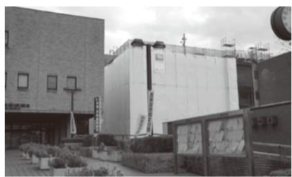
田無庁舎の中庭に建設中の仮庁舎
