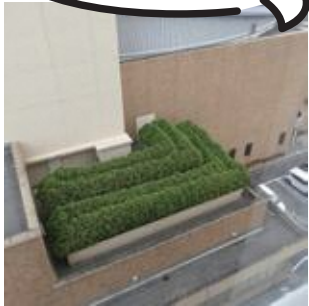
タクトホームこもれび GRAFARE ホール（保谷こもれびホール）の 屋上緑化
