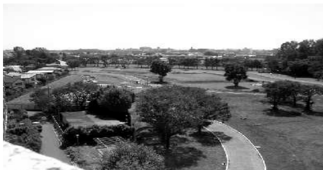
整備中の(仮称)合併記念公園(西東京いこいの森公園)
