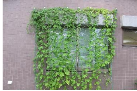
東伏見コミュニティセンター
