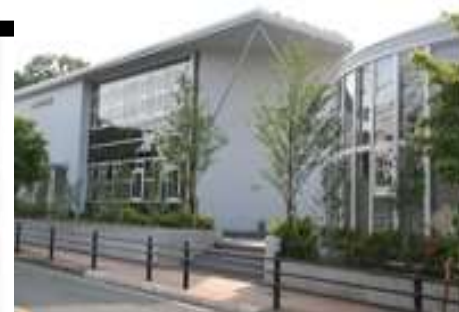
④エコプラザ西東京 (泉町3丁目)
