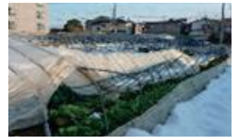
平成26年雪害の被害
