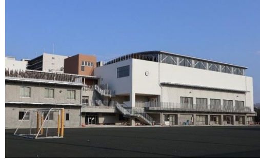
ひばりが丘中学校新校舎（平成30年12月竣工）
