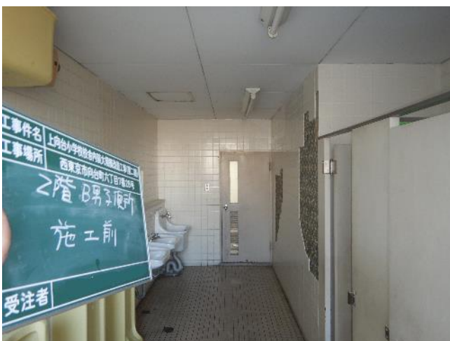
施工前（男子トイレ）
