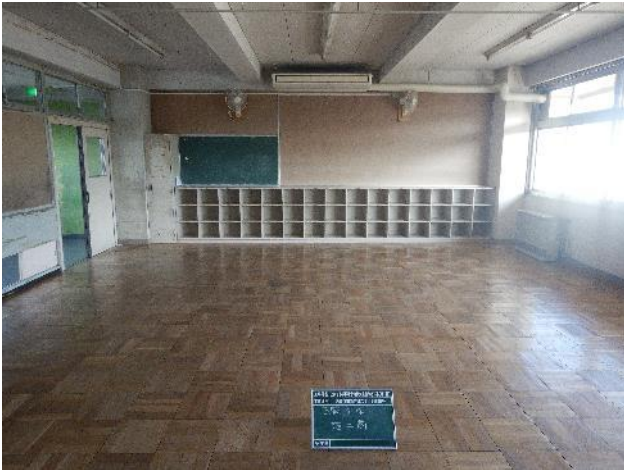
上向台小学校 施工前（普通教室）
