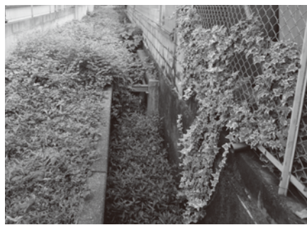
暗渠になっていない水路
