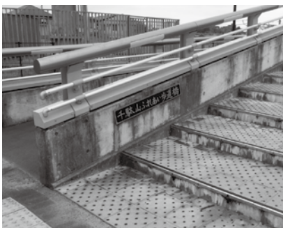
千駄山ふれあい歩道橋
