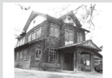
旧保谷市役所 昭和42(1967)年撮影 西東京市中央図書館地域・行政資料室所蔵
