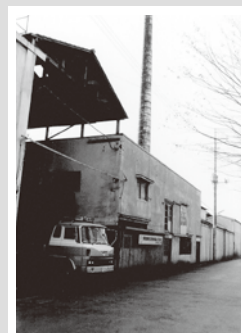
東鳩製菓保谷工場(撮影年不詳) 西東京市中央図書館地域・行政資料室所蔵
