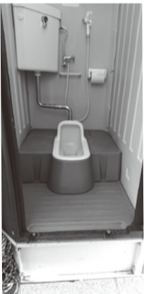
仮設トイレ 段差があるため、車イスでは自力で入ることができません
