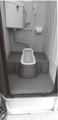
仮設トイレ 段差があるため、車イスでは自力で入ることができません
