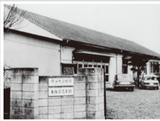
保谷町公民館(撮影年不詳) 西東京市中央図書館地域・行政資料室所蔵
