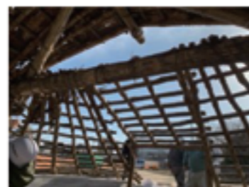
復元住居の屋根工事
