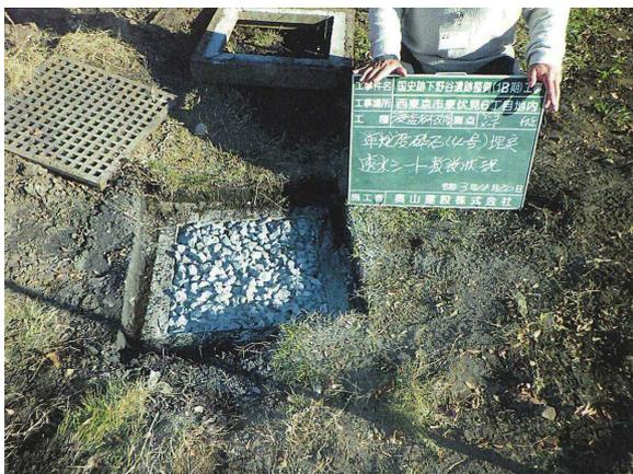
既存浸透柵埋戻し（砂利充填）
