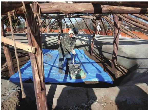
床面三和土締固め状況
