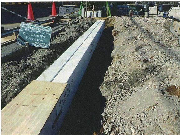
雨水溝（スリット型）設置
