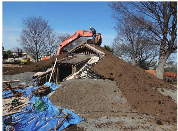
写真 16 葺土施工状況
