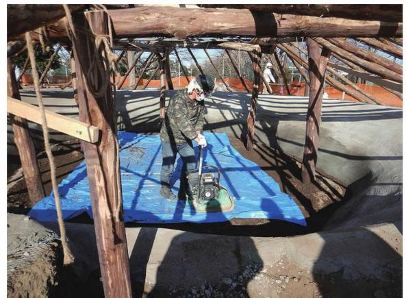
写真 17 床面三和土締め固め状況
