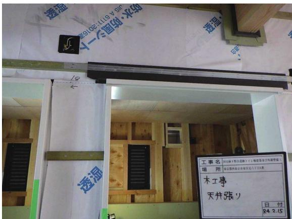
木工事（防水・断熱ボード設置）
