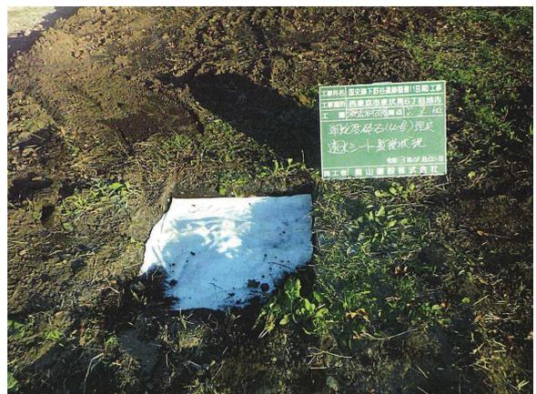
既存浸透柵埋戻し（透水シート設置）
