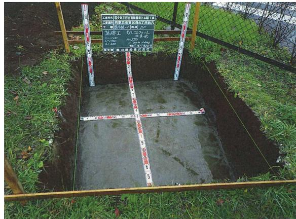
基礎均しコンクリート打設
